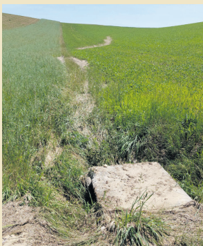
Abb. 1: Bevorzugte Abflussschneisen – Schäden an Infrastruktureinrichtungen und Oberflächengewässern sind vorprogrammiert. BWSB/WALLNER
